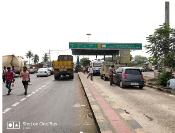
Fig: Toll Plaza
