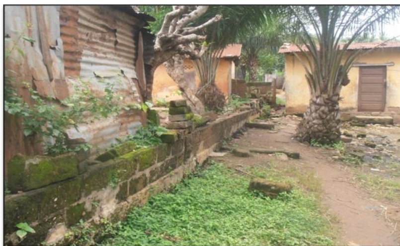
Photo 3 : Maisons bâtie en zone non-aedificandi Source : Lakoussan
